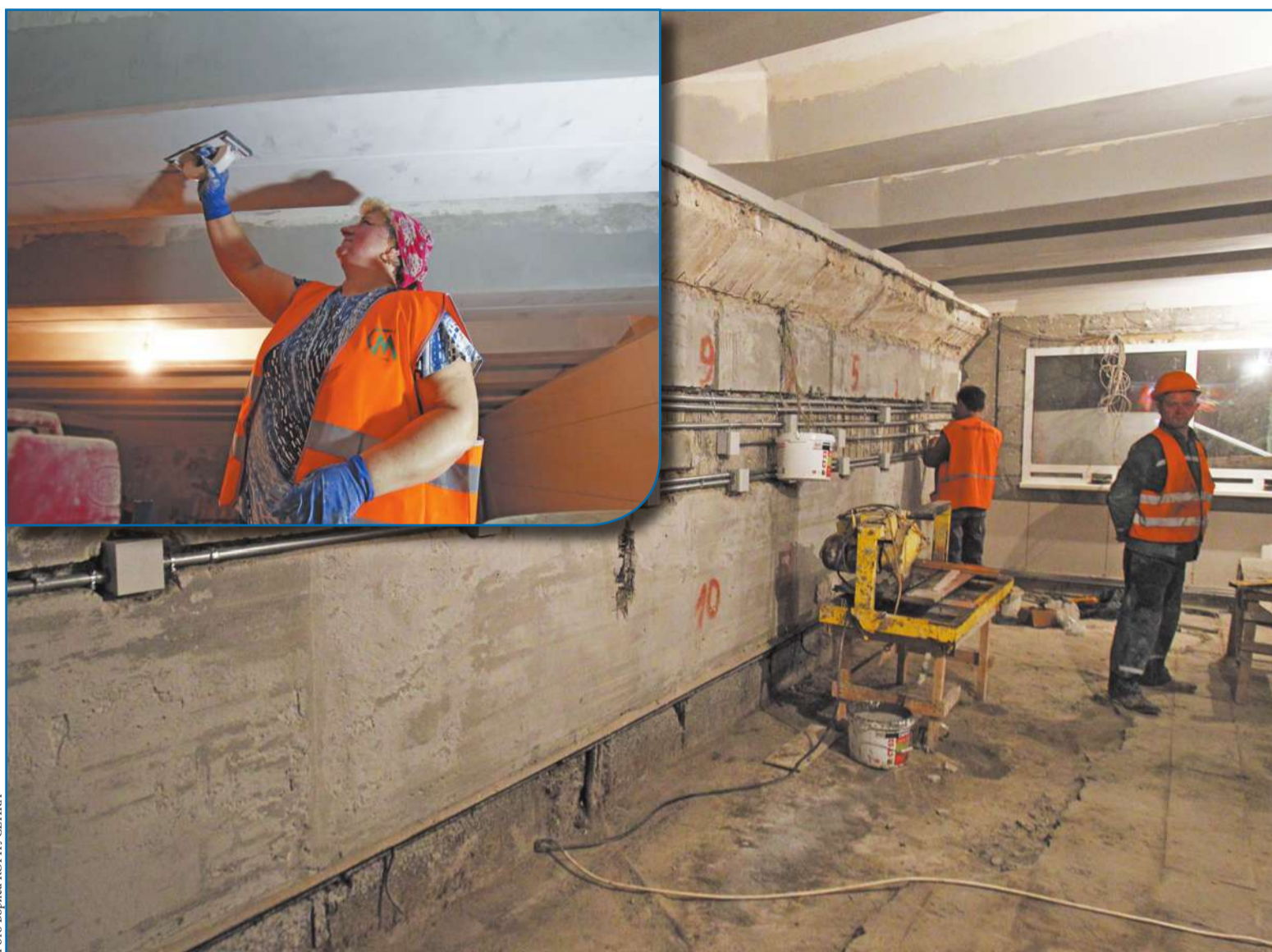
На станції столичного метрополітену «Святошин» у рамках проведення капремонта виконано демонтаж штукатурки та кахельної плитки у вестибюлі № 1 та прилеглому підземному переході, тривають роботи з гідроізоляції колійних стін тощо
