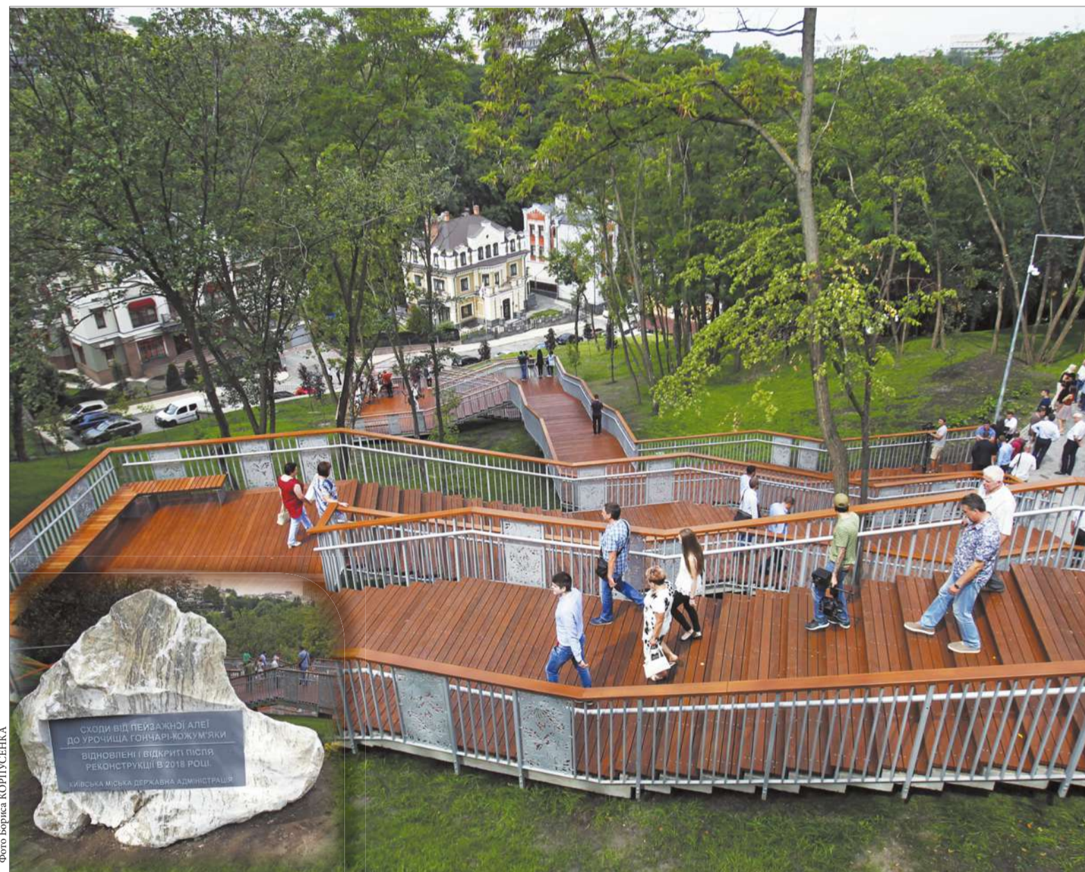
Після реконструкції в столиці відкрили оновлені сходи від Пейзажної алеї до урочища Гончарі-Кожум'яки. Вони зроблені з бетону, проте самі сходинки, як і раніше, дерев'яні – зі зносостійкої та вологозахисної термодеревини
