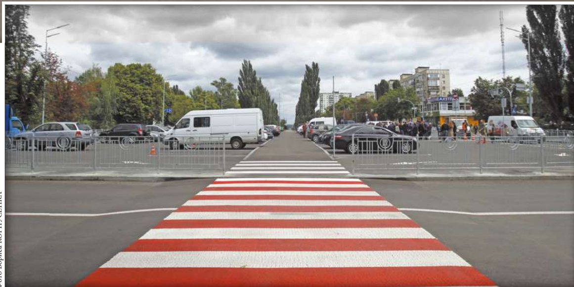
У Святошинському районі столиці триває капітальний ремонт бульвару Академіка Вернадського, а нещодавно київавтодорівці розпочали оновлення ще однієї великої транспортної магістралі – проспекту Академіка Палладіна
