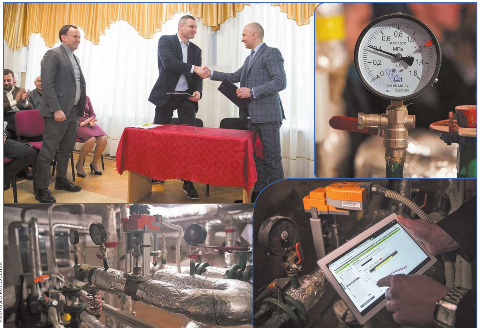
Завдяки встановленій у столичному дитсадку № 402 системі контролю за споживанням тепла можна дистанційно моніторити температуру в приміщеннях, управляти обладнанням індивідуального теплопункту
