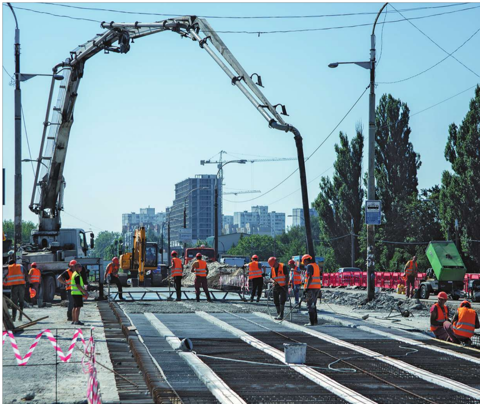
Рух трамваїв шляхопроводом планують відновити вже з 1 вересня, а повністю його облаштують навесні 2018-го
