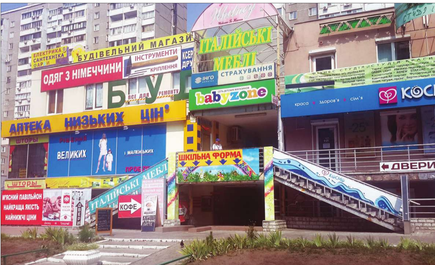
Реалізація норм нових правил розміщення реклами, зокрема фасадної, забороняє суцільні вивіски у центрі столиці, перекриття фасадного декору, вікон, встановлення конструкцій вище першого поверху, на балконах
