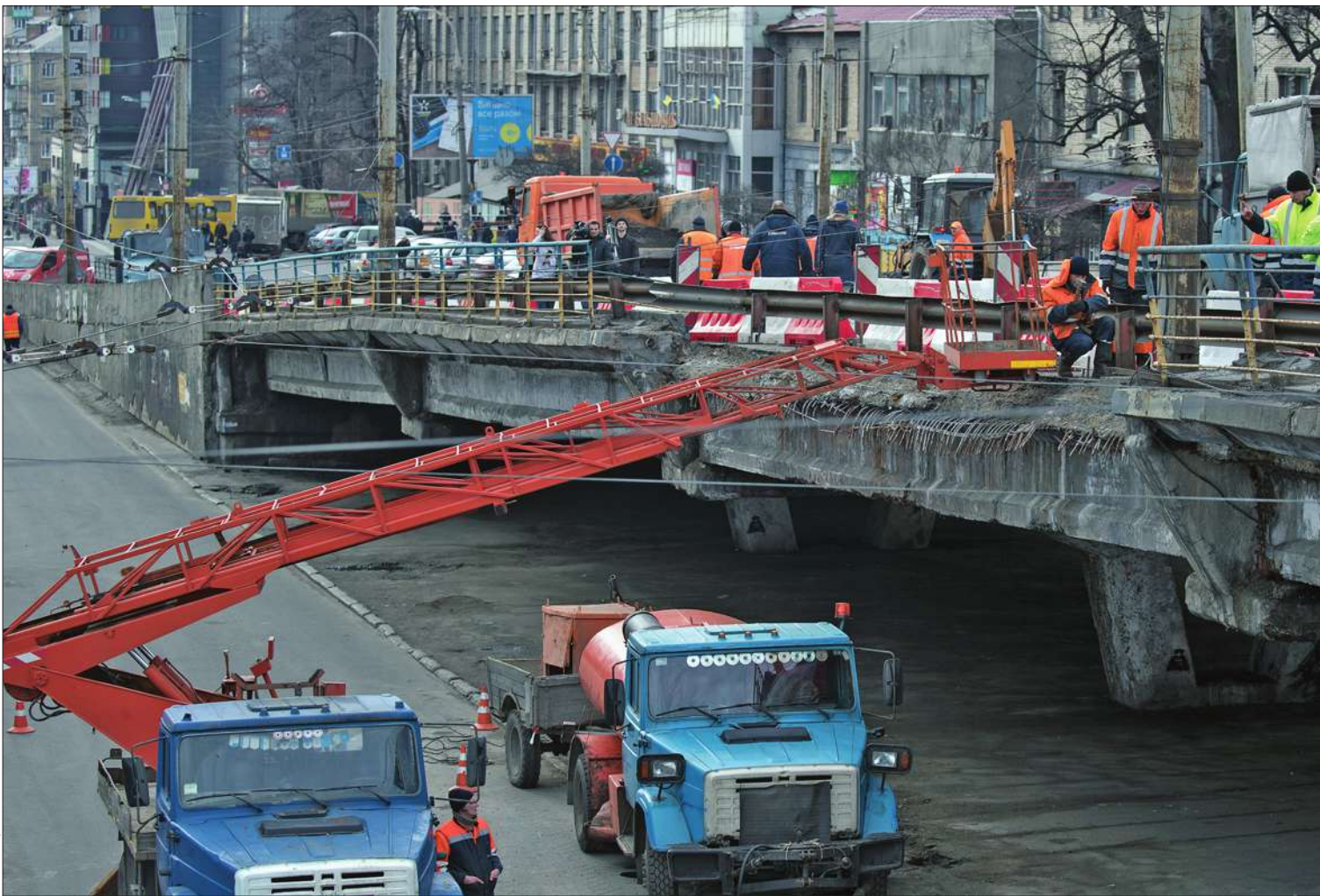
На Шулявському шляхопроводі вже розпочалися роботи з його укріплення. Рух авто тут обмежать, а проїзд важкового транспорту заборонять узагалі
