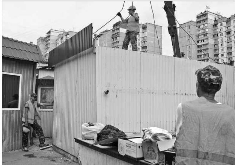
Минулого тижня на вул. Бальзака, 64-66 міська влада розпочала демонтаж 50-ти МАФів, з яких вже більше половини відправлено на штрафмайданчик
