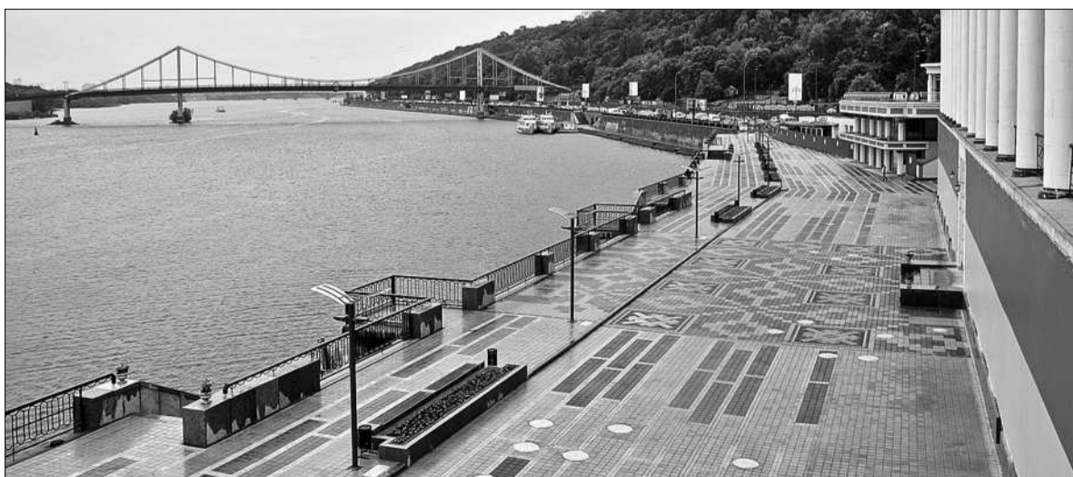
Реконструйована набережна протяжністю 700 м дає можливість вільного проходу з історичної частини Подолу через підземний пішохідний перехід (Набережне шосе) до пам'ятника Магдебурзькому праву і пішохідного мосту
