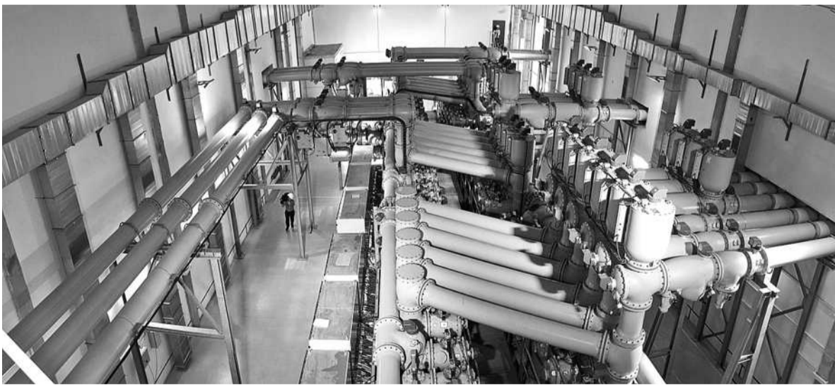
Минулого тижня ПАТ «Київенерго» завершило будівництво стратегічно важливого об'єкта як для столиці України, так і вітчизняної енергетики в цілому
