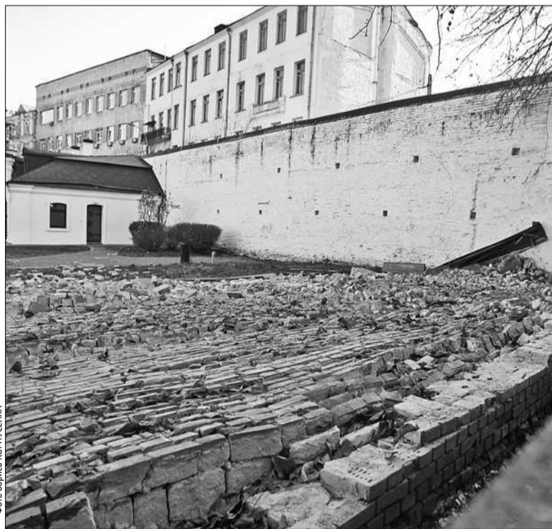
Фахівці вважають, що роботи на теплотрасі, які передували обвалу стіни в заповіднику, проводились з порушенням державних будівельних і реставраційних норм, закону про охорону культурної спадщини
