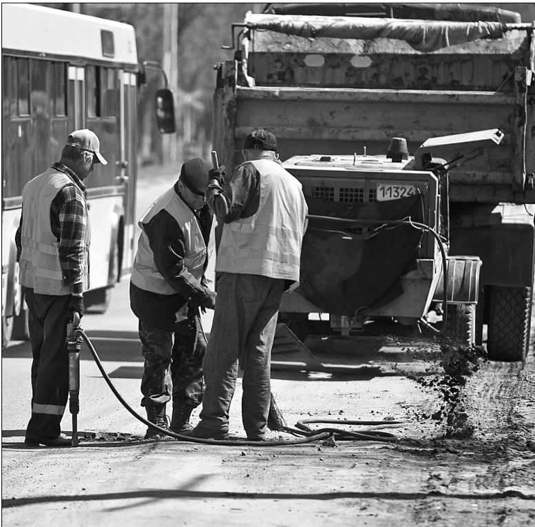
Наразі київавтодорівці проводять капітальний ремонт дорожніх покриттів вулиць у трьох районах столиці
