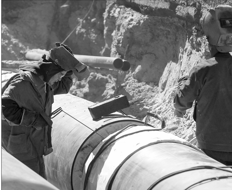
Наразі столичні комунальники ремонтують та замінюють ізоляцію трубопроводів центрального опалення й гарячого водопостачання у підвалах і на горищах житлових будинків
