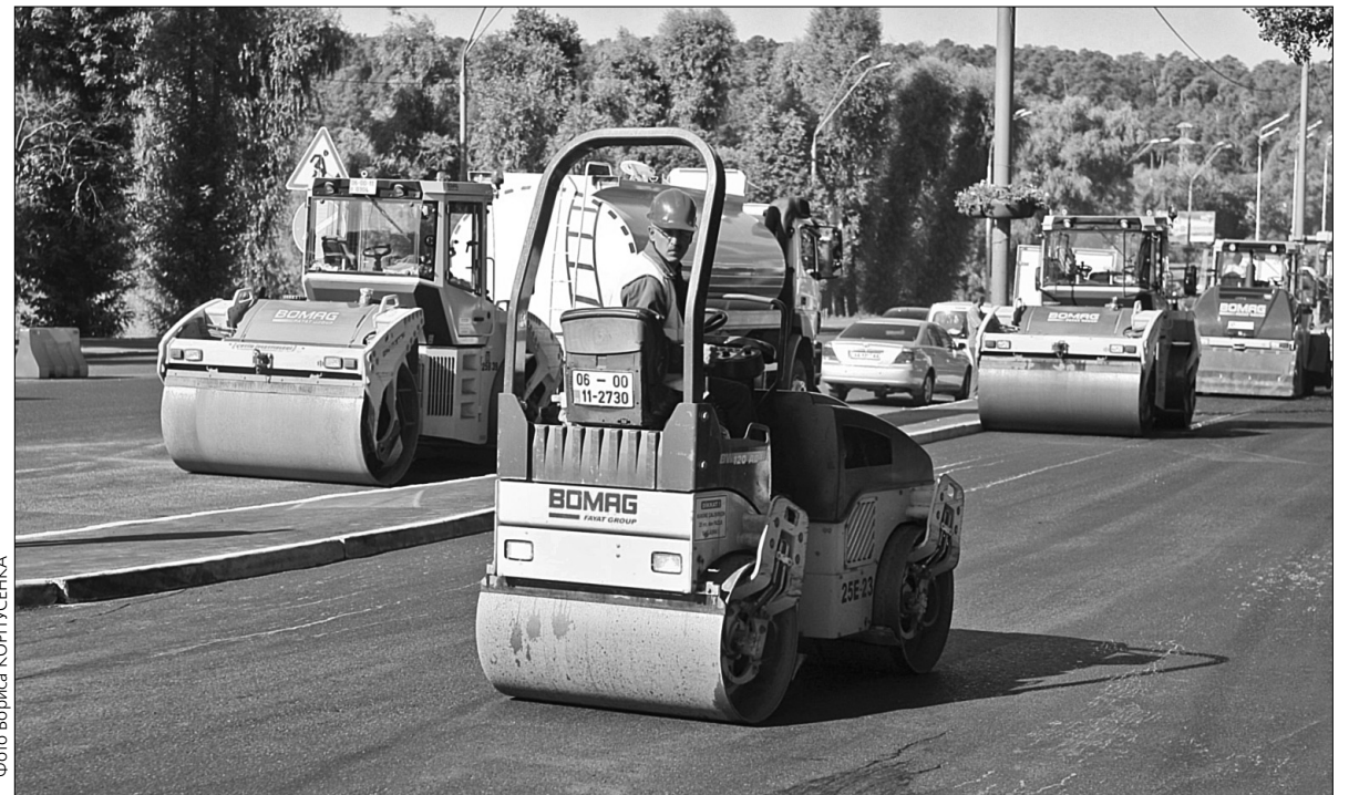
Окрім проспекту Перемоги, капітальні ремонтні роботи у місті тривають ще на 26-ти вулицях
