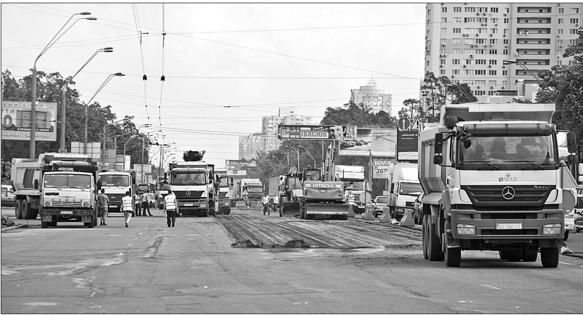
Під час реконструкції проспекту Перемоги дорожники фрезерують старе та готуються укласти нове асфальтобетонне покриття
