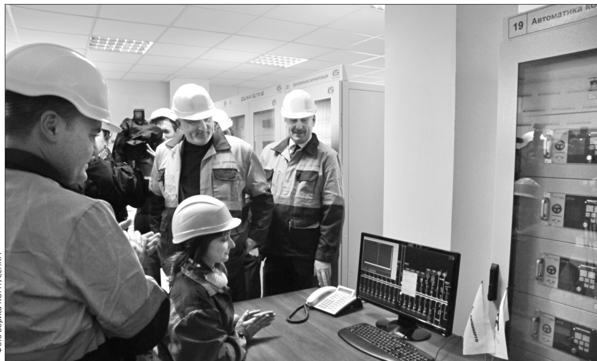
Відчора енергопостачання у центральну частину міста здійснюється із нової підстанції "Московська"
