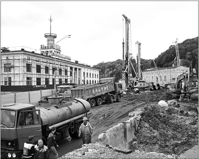
У грудні, після того як будівельники візьмуться за спорудження другої частини тунелю, техніку перемістять ближче до будівлі Річкового порту
