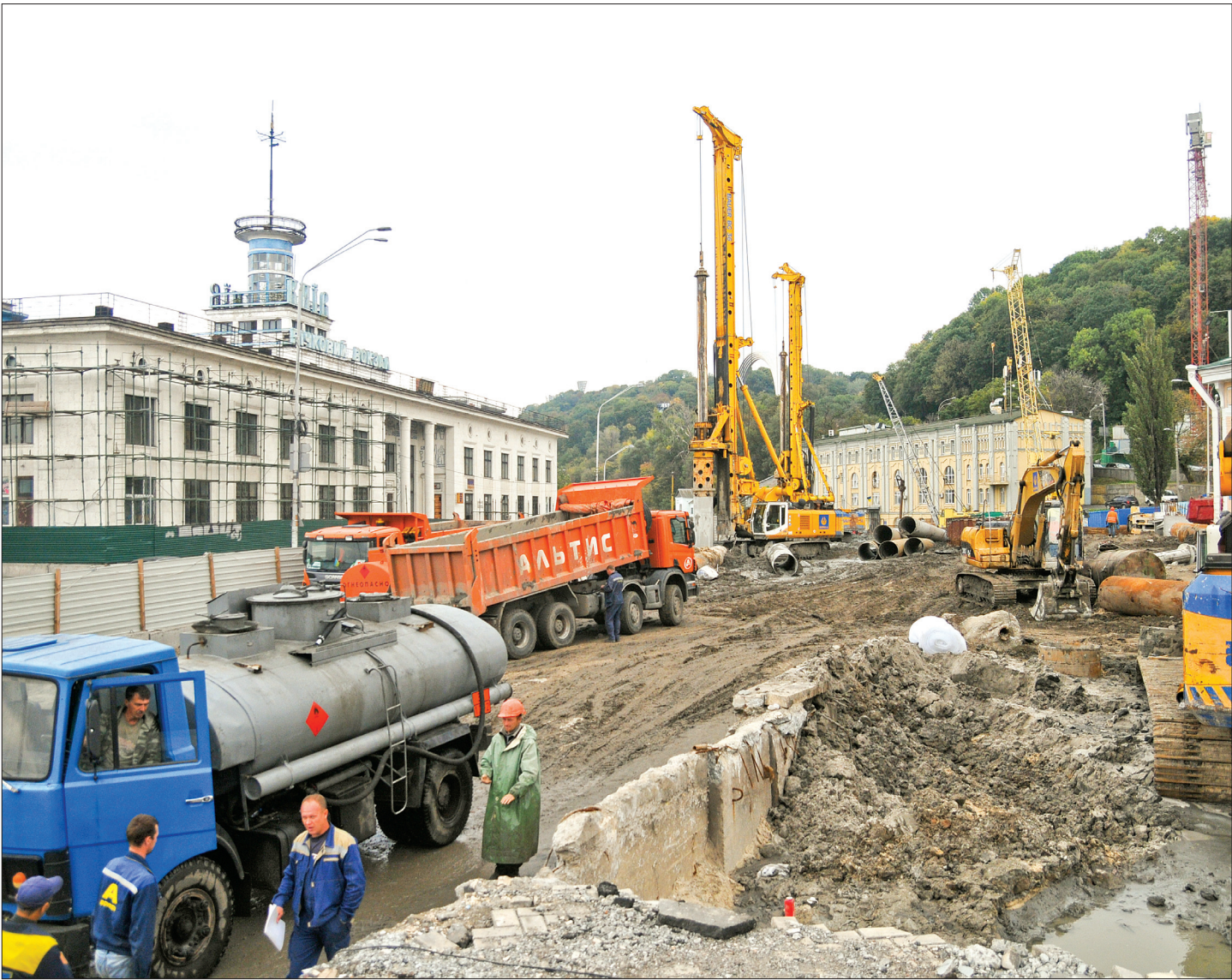
Наразі на Поштовій площі проводиться перекладання та заміна всіх інженерних комунікацій
