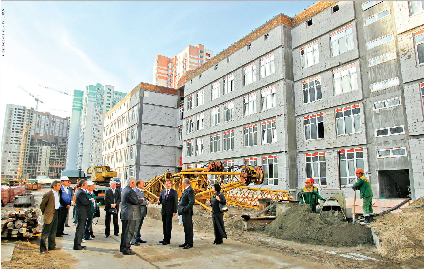
Наразі вже збудований перший корпус майбутньої школи. На об'єкті тривають внутрішні та зовнішні оздоблювальні роботи
