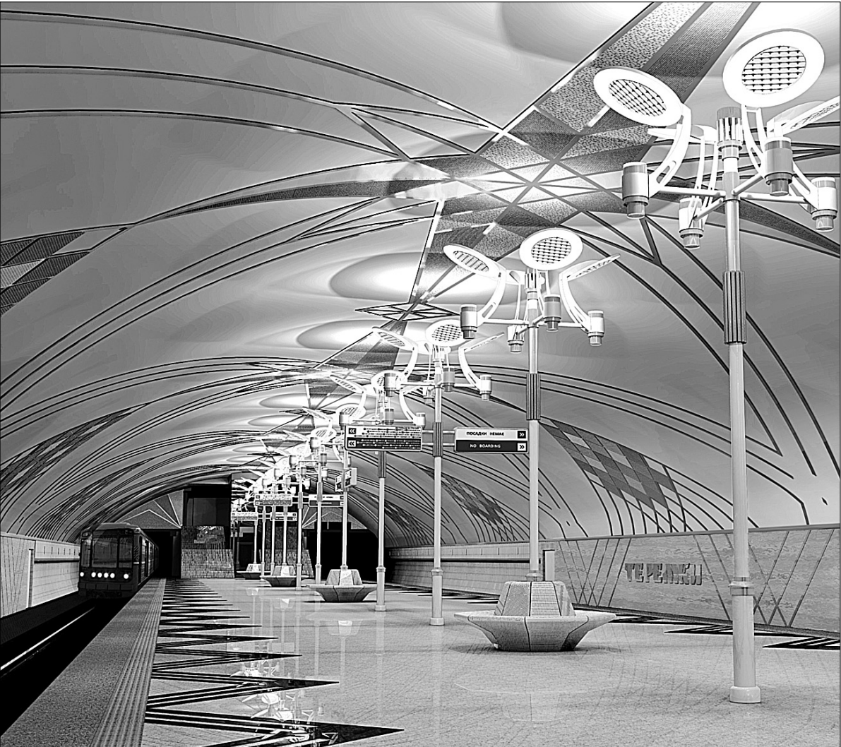
При облаштуванні станції “Теремки” використовуватимуть традиційні матеріали: для підлоги міцний і довготривалий граніт, при оздобленні платформ і вестибюлів - вітчизняний мармур
