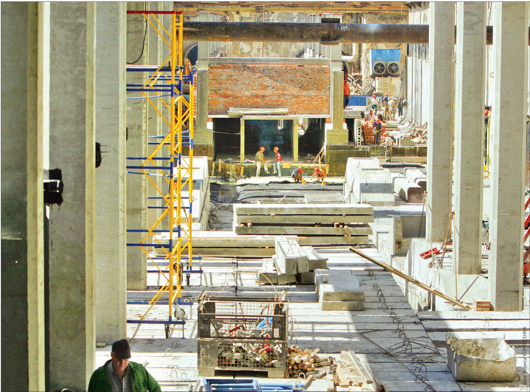
Так нині виглядає майбутня станція "Іподром". Після монтажу конструкцій, вже за місяць, тут розпочнуться оздоблювальні роботи
