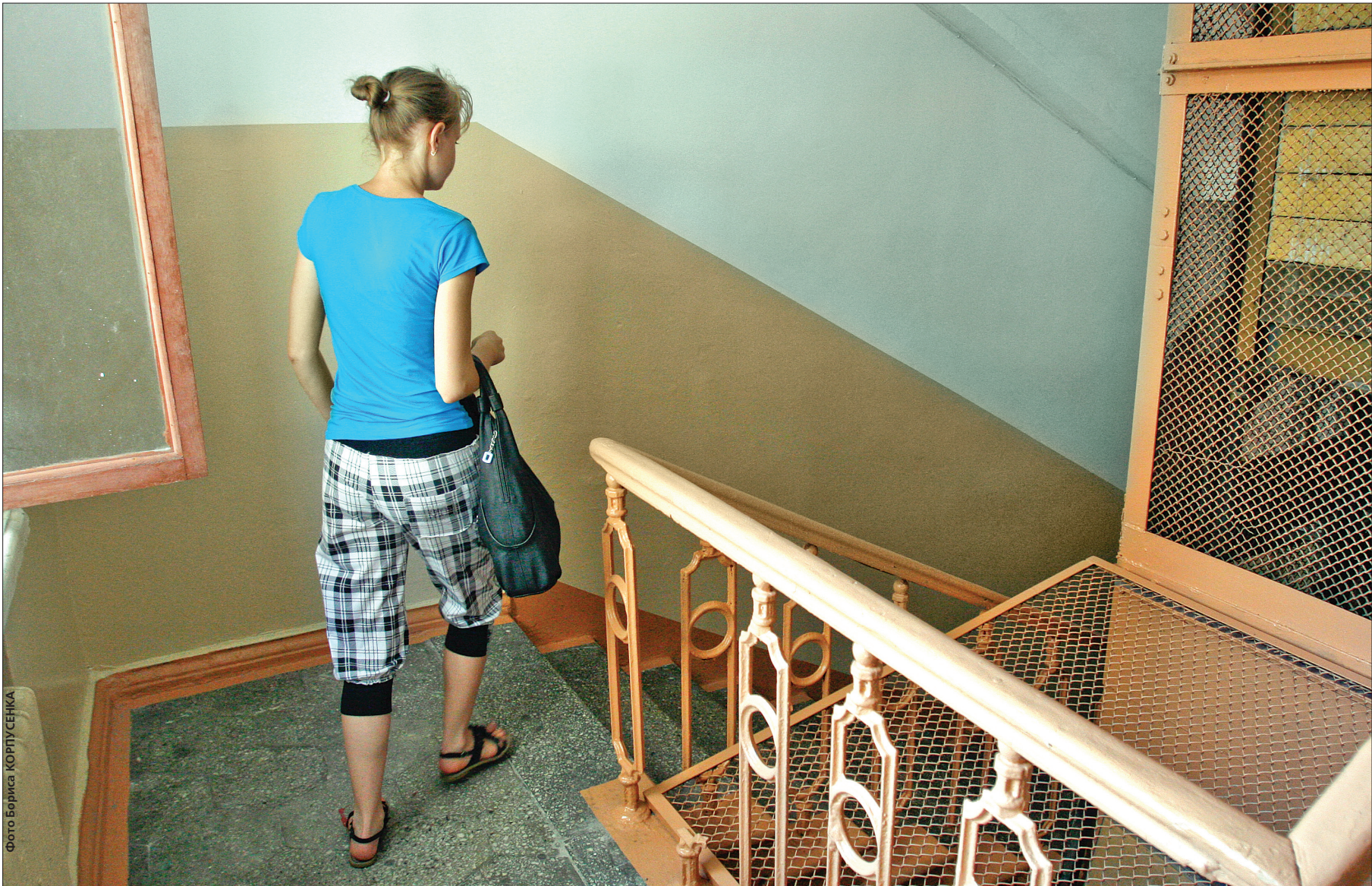
Сходові клітини в будинку на вулиці Саксаганського, 118 вражають чистотою та якістю ремонту
