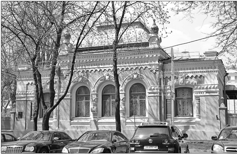
Особняк на вул. Липській, 2, який належав банкіру Філіппову
