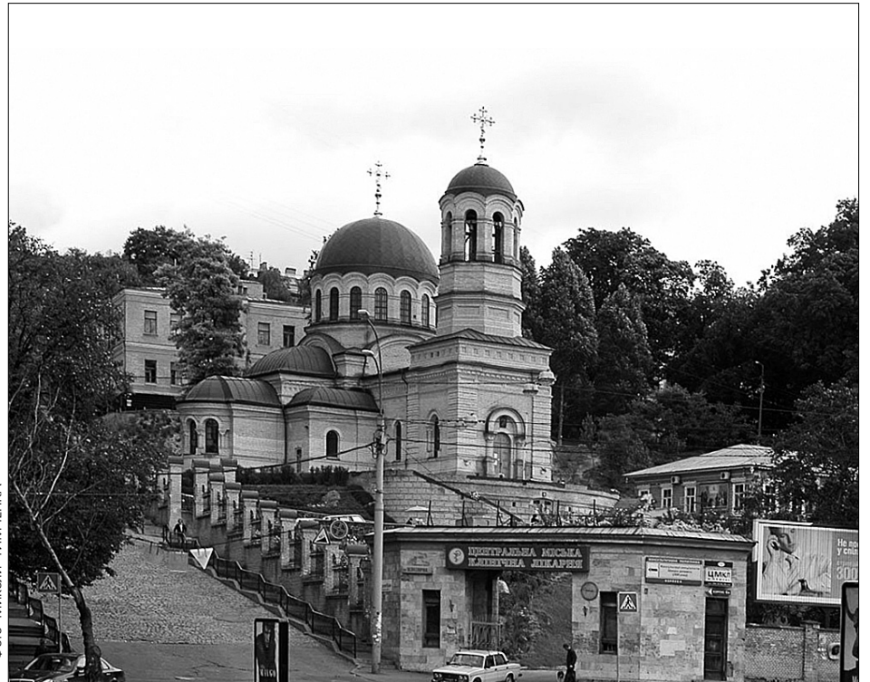
Найближчим часом відбудеться нарада щодо можливості перенесення проблемного будівництва з території Олександрівської лікарні в інше місце
