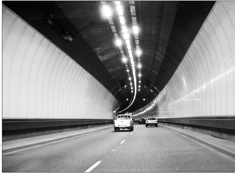
Розв'язати проблему з пробками в столиці допоможе будівництво сучасних автомобільних тунелів
