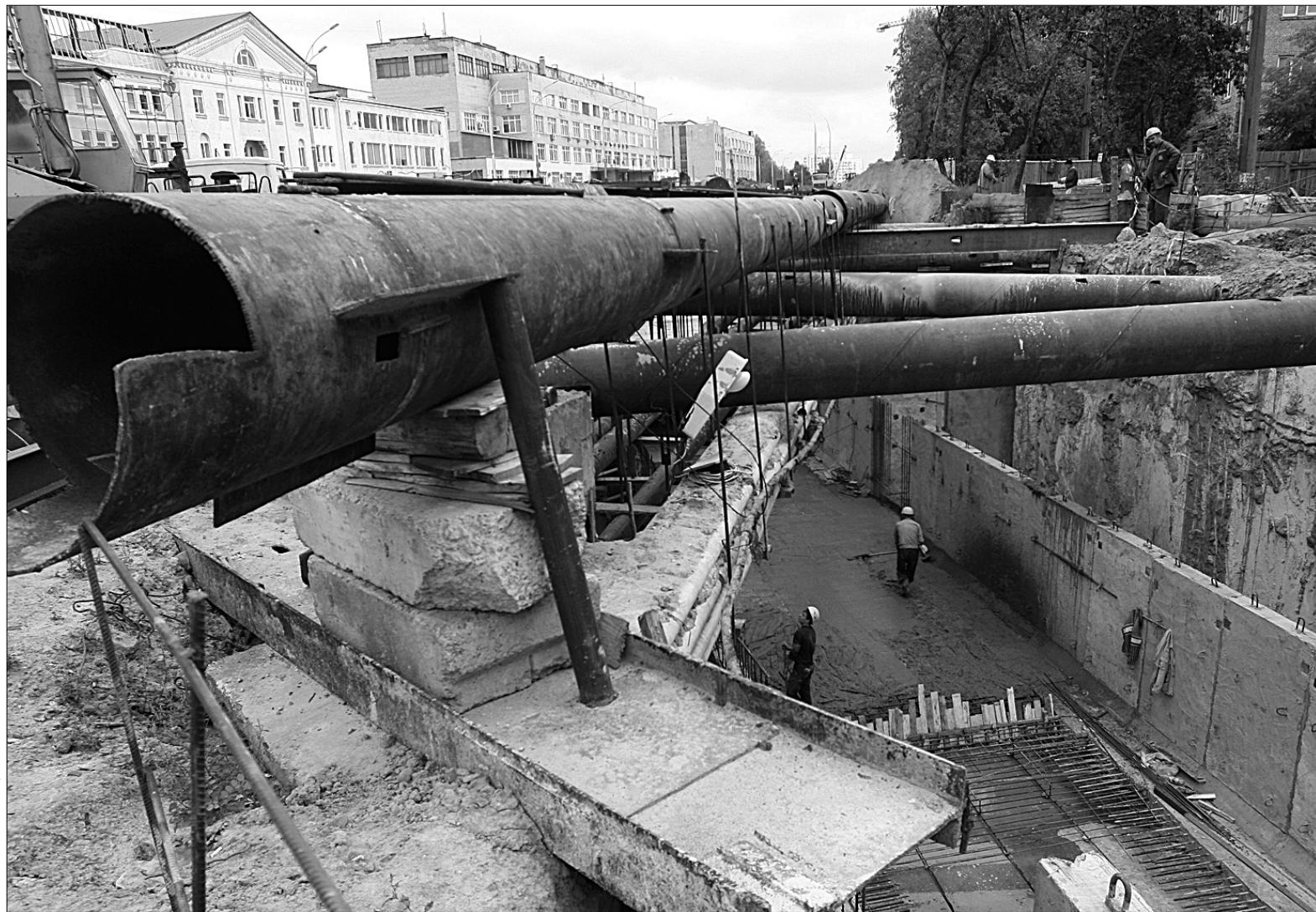
Колись це назвуть головною будівлею 2010 року
