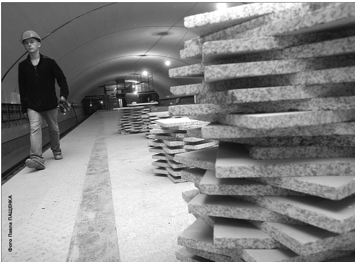
На станції «Васильківській» наразі прокладено колію, закінчують облицювання стін
