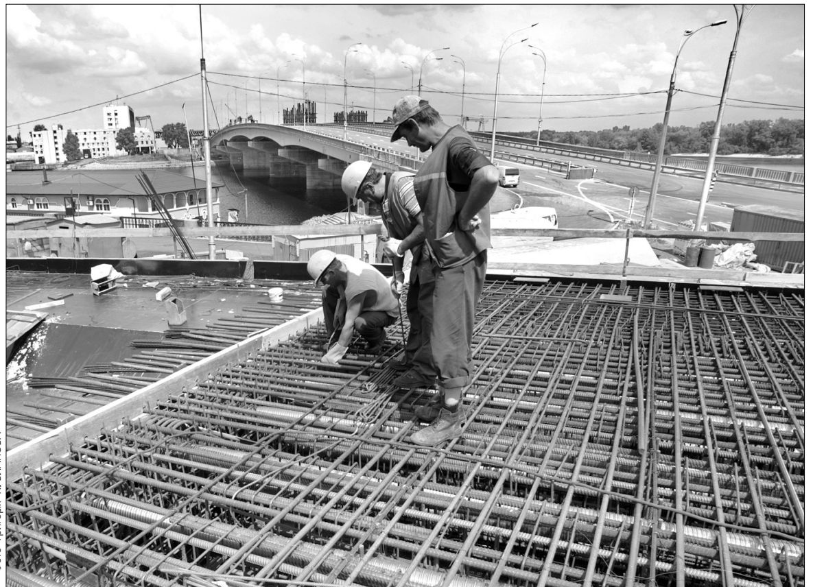
Нині мостобудівці завершують спорудження естакади Гаванського мосту
