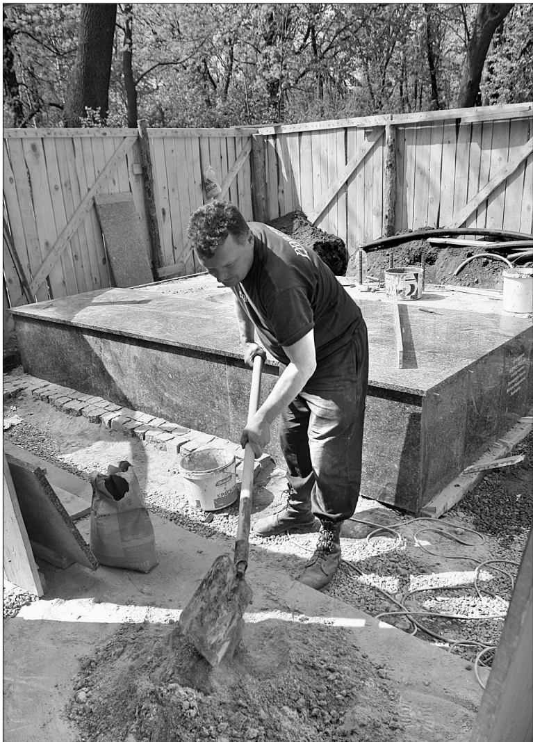
Для пам'ятника Івану Кожедубу у парку Слави уже залили постамент, поряд ремонтують сходи біля обеліска Невідомому солдату
