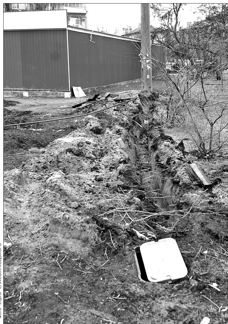
Влада Дарницького району розбирається, хто повинен ліквідувати аварійні розриття на вулицях
