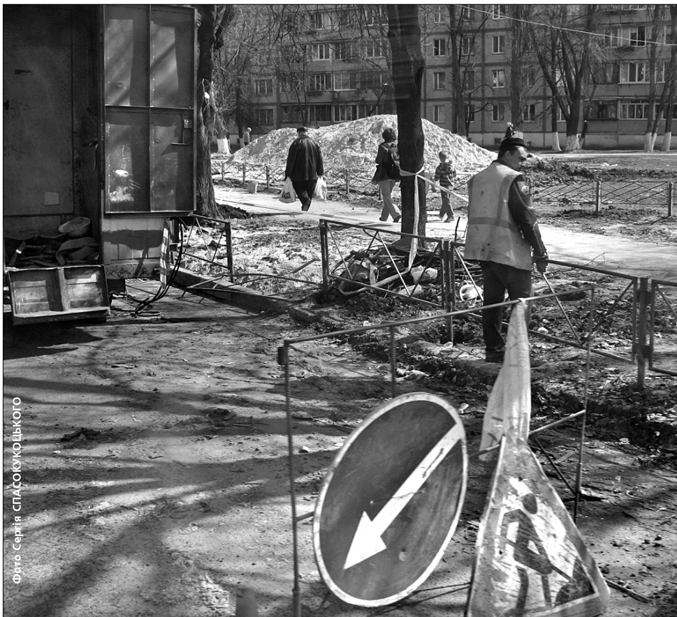
Вистачає роботи в районі й з ремонту огорож та мереж
