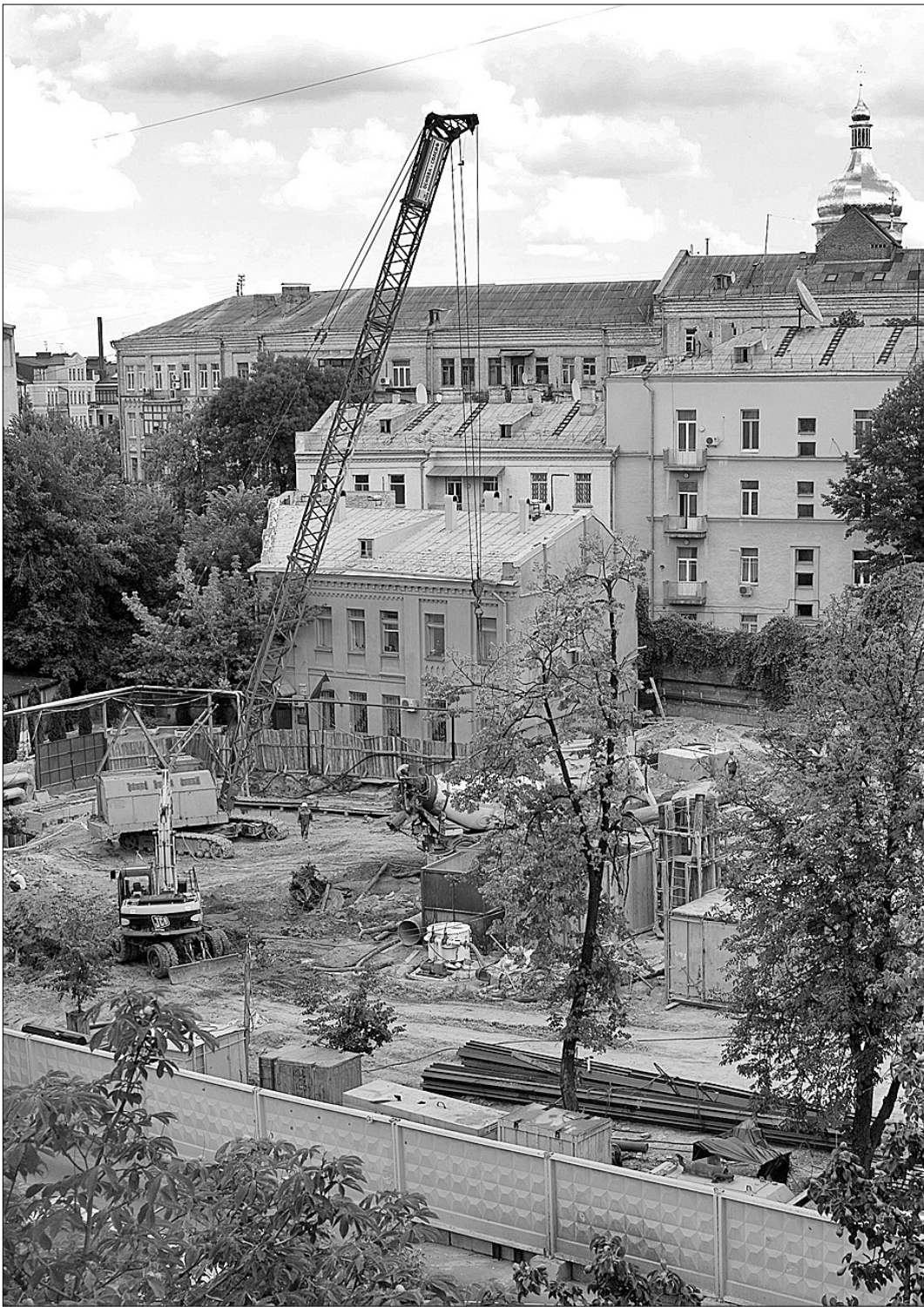
Будівельні крани незабаром зникнуть з центру міста
