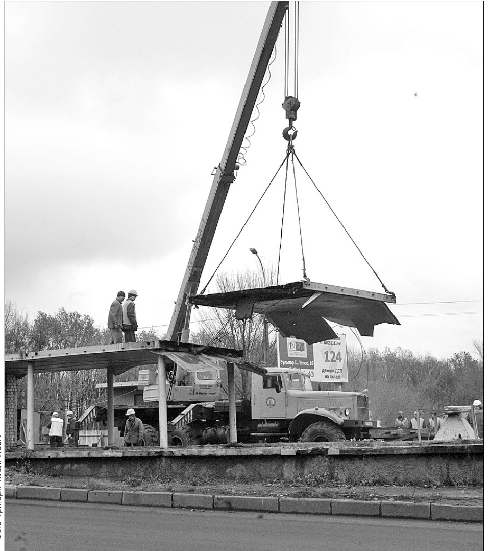
На лінії швидкісного трамвая будівельники демонтують старі конструкції зупинкових комплексів та встановлюють нові
