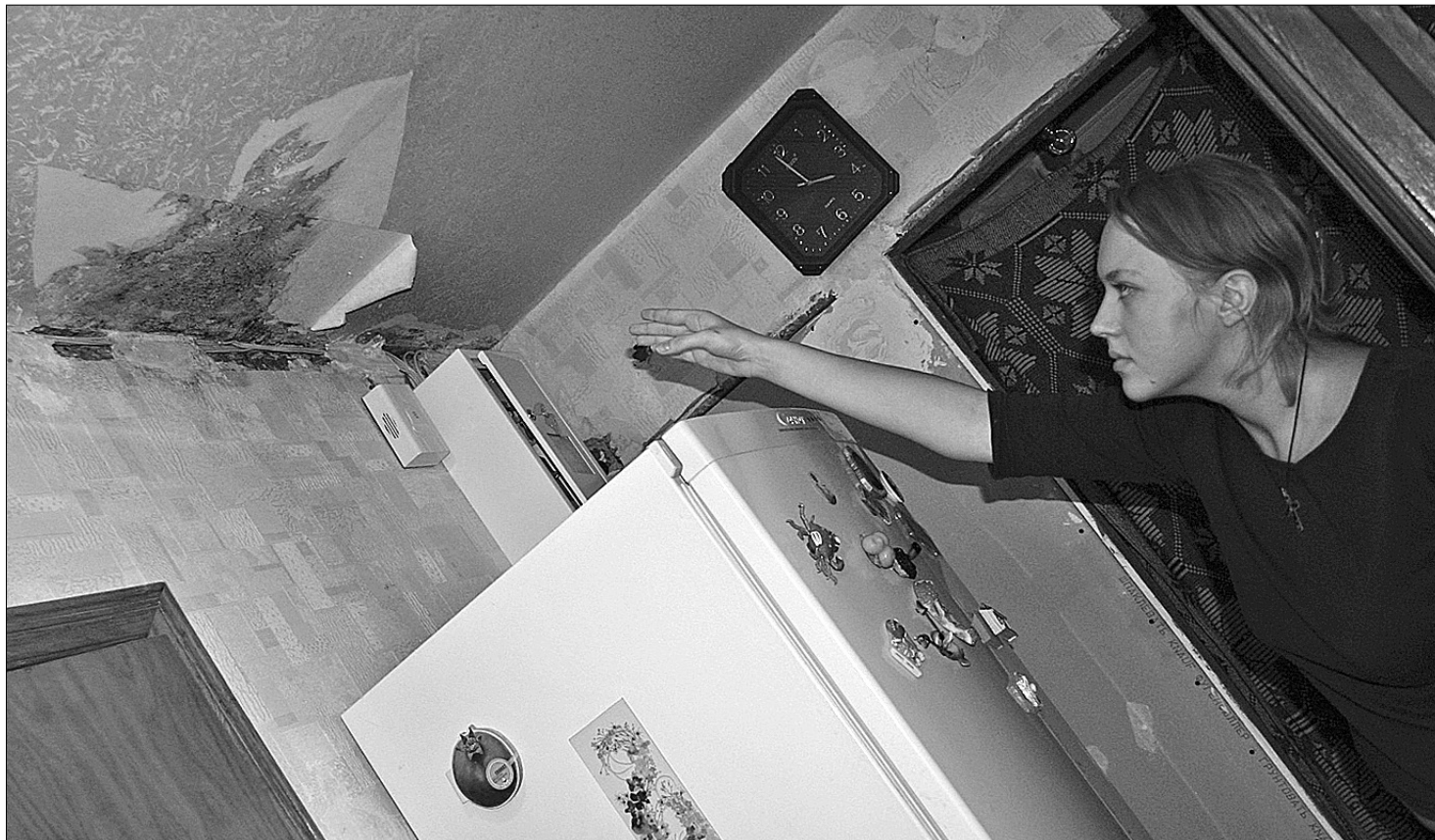
Власниця квартири № 239 на Дарницькому бульварі, 7 Юлія Пошедіна показує, що протікання знову загрожує електричному щитку, який один раз уже переносили
