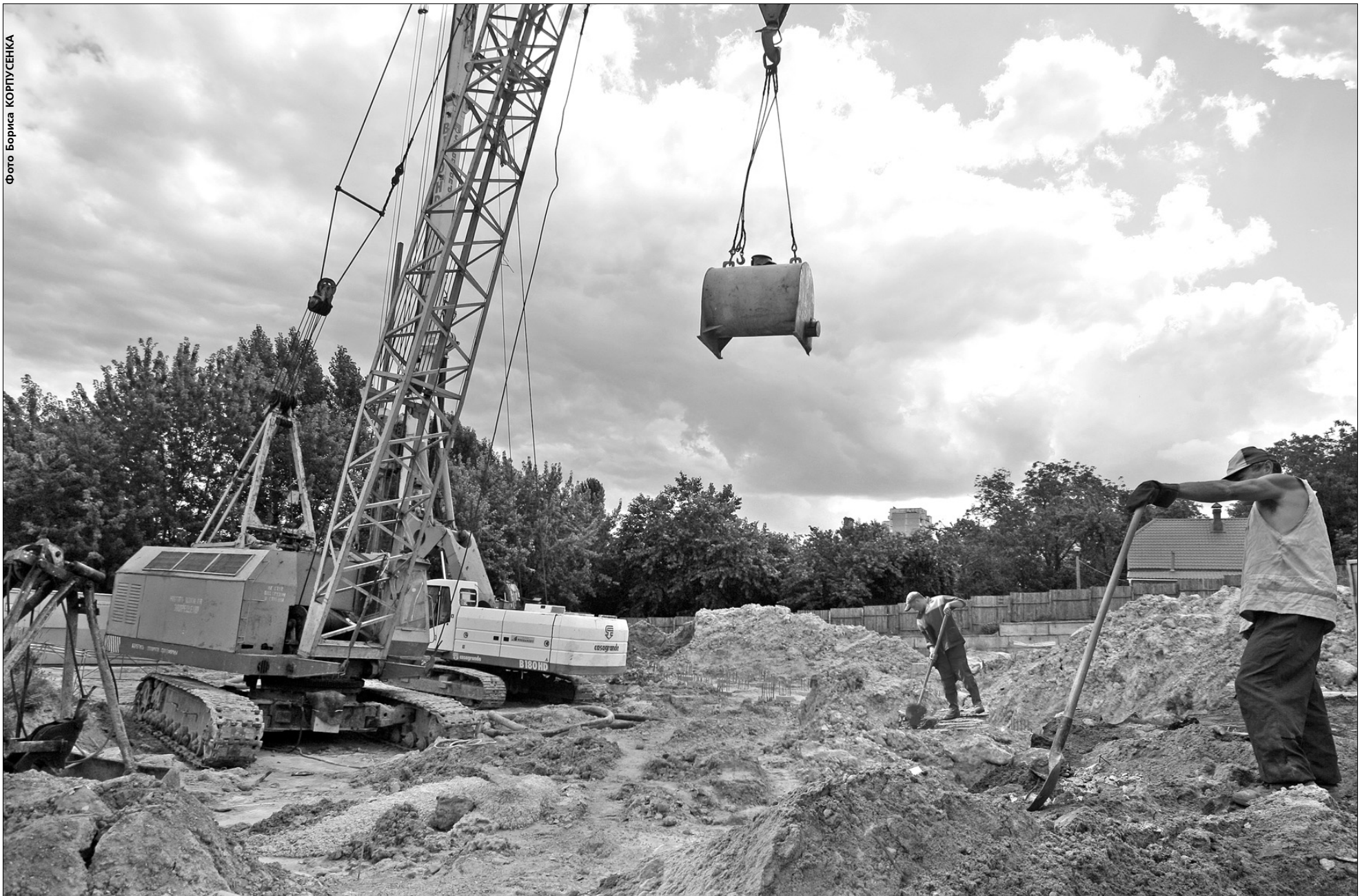
За рік на місці котловану на проспекті Правди постане висотка для "елітівців", обіцяють у "Київміськбуді"
