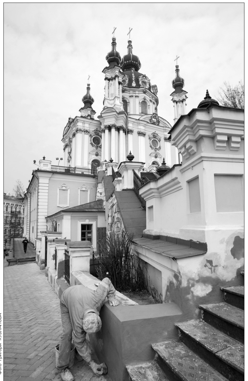
Андріївська церква терміново потребує капітальної реконструкції — тимчасове латання тріщин не допомагає
