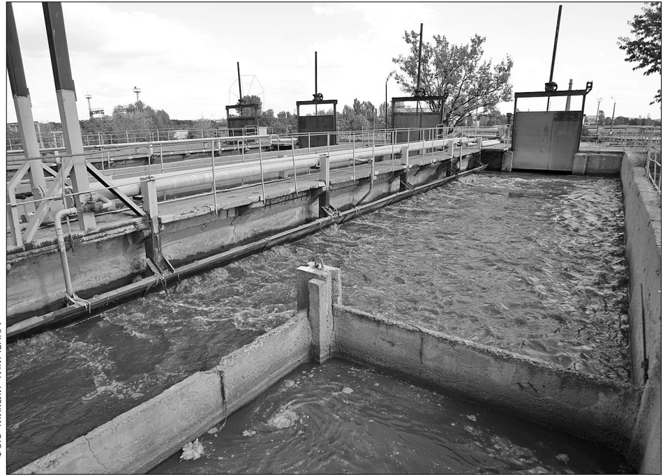
Через застаріле обладнання на Бортницькій станції аерації постійно трапляються прориви та витік стічних вод
