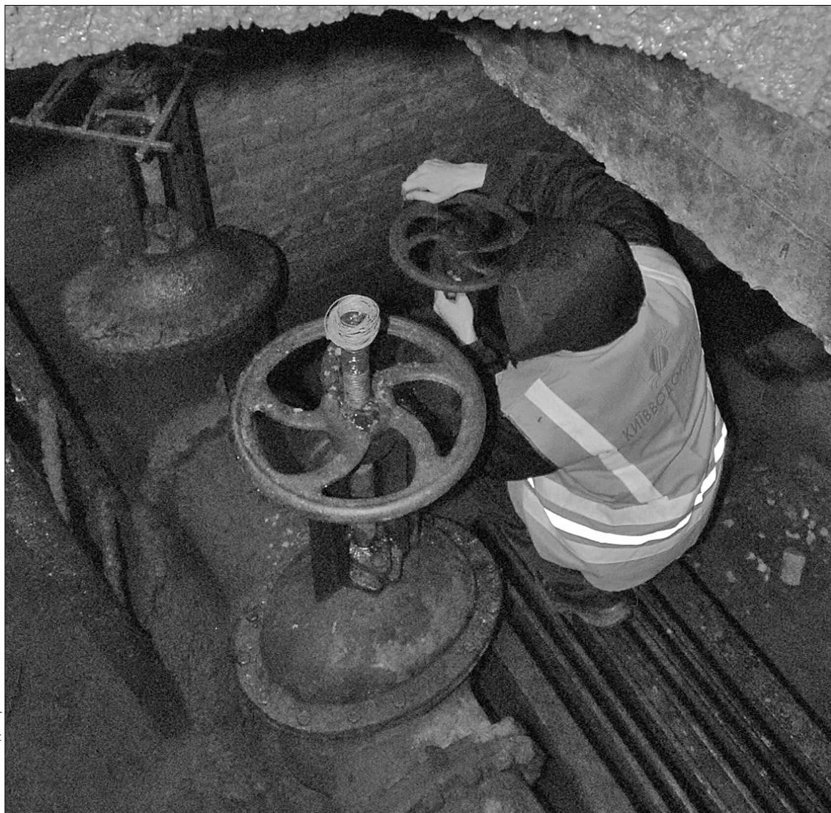
Через власні борги компанія "Київенерго" змушена відключати об'єкти водопостачання від енергоживлення
