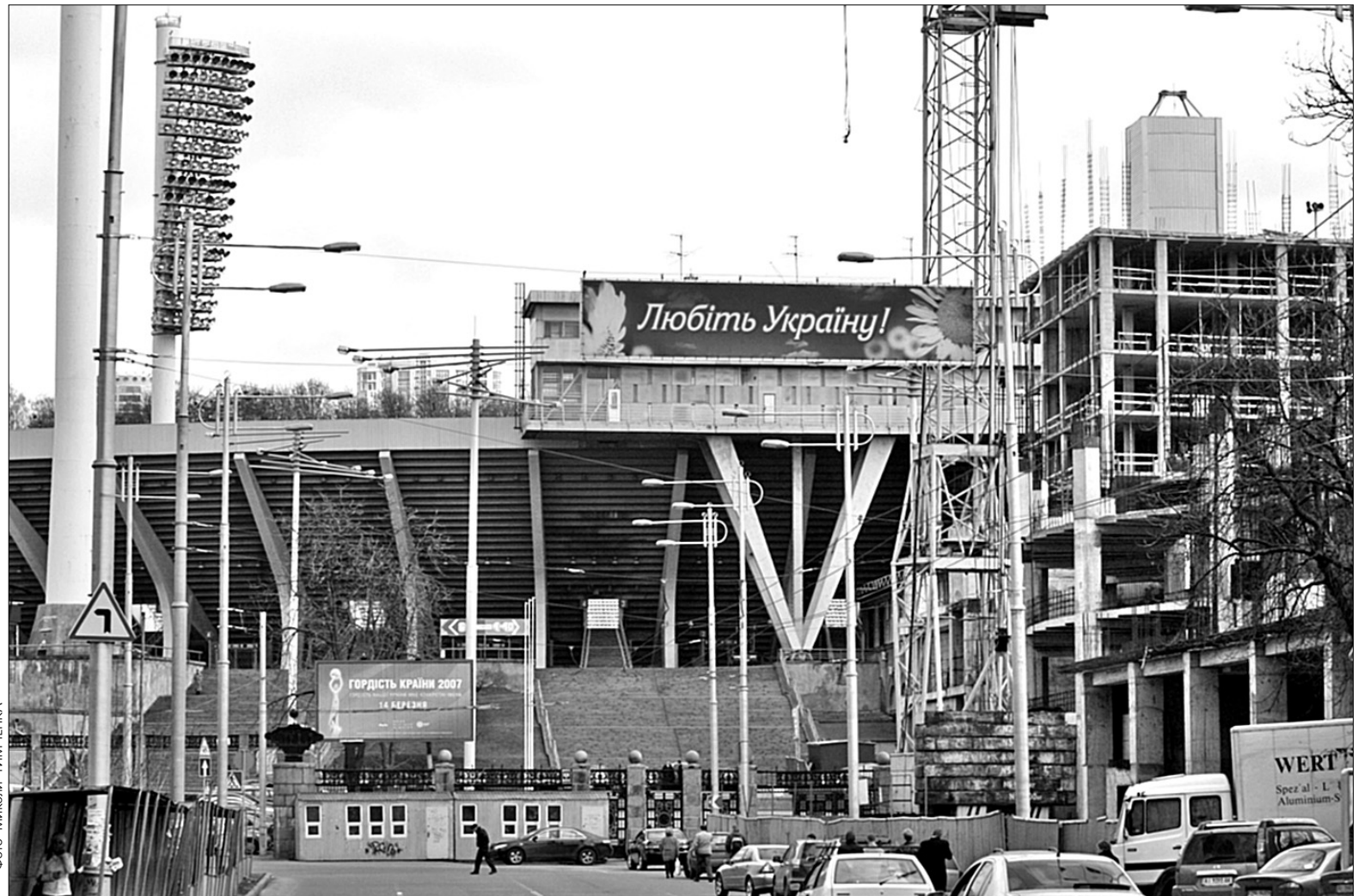
Демонтаж "Троїцького" та реконструкція НСК "Олімпійський" гарантують проведення Євро-2012 в Україні
