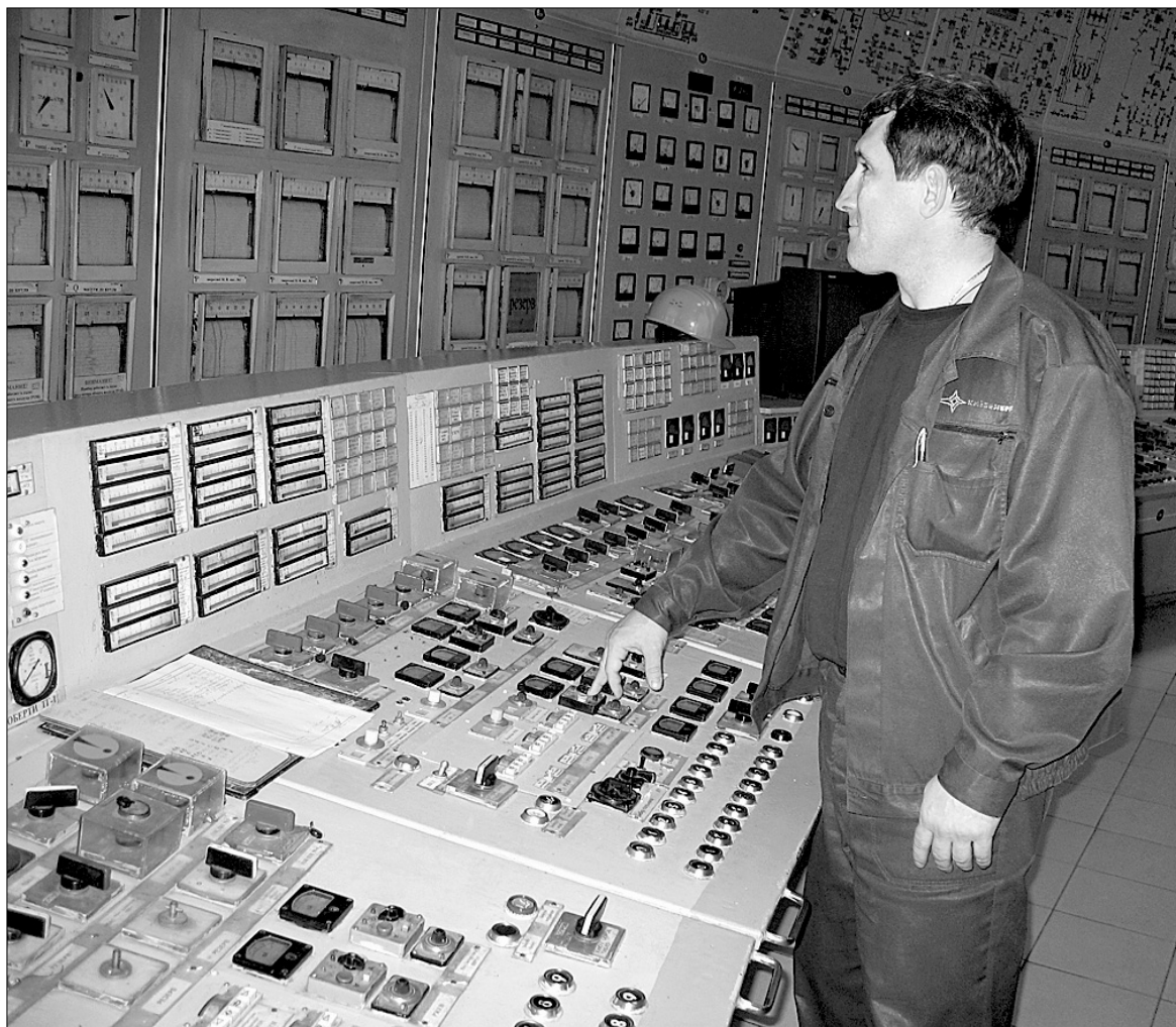
Фахівці уважно слідкують за показниками датчиків у блочному щиті управління турбінного цеху ТЕЦ-6
