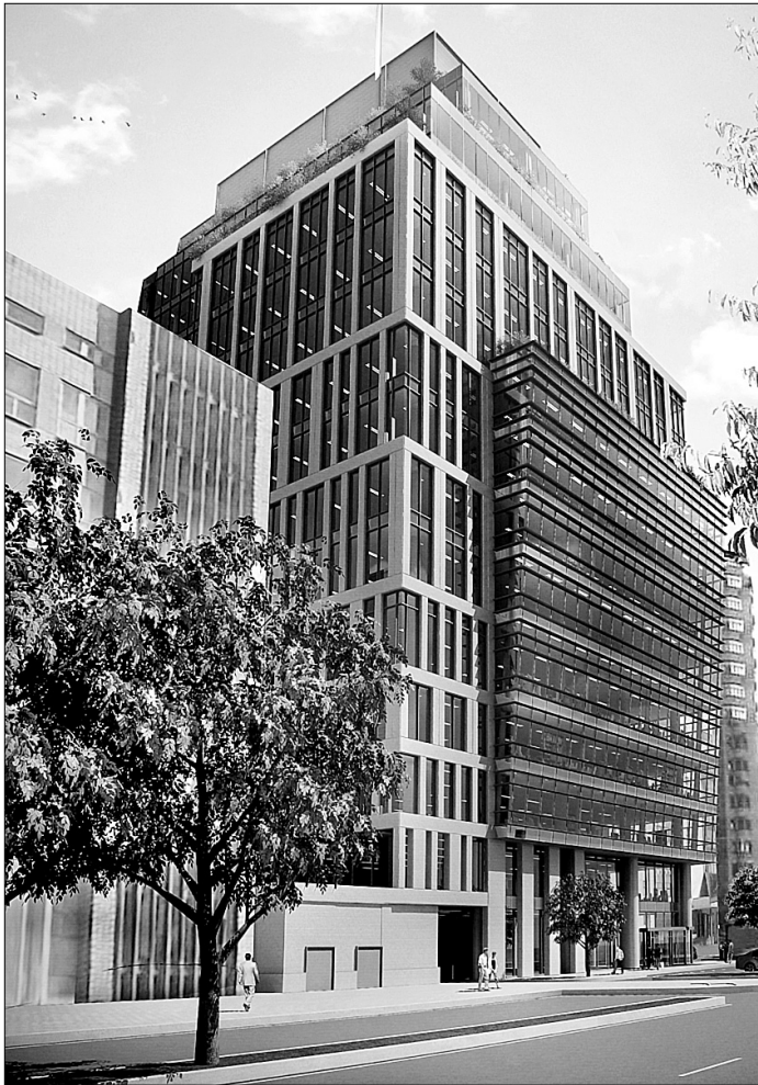
У перші 5 поверхів висотки на вулиці Кутузова, 18/7 переселяться печерські правоохоронці, інші приміщення передбачено під офіси
