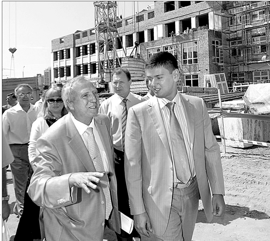
Перший заступник голови КМДА Денис Басс відвідав будмайданчик на вул. Кавказькій, 10, де триває реконструкція спеціалізованої школи № 115
