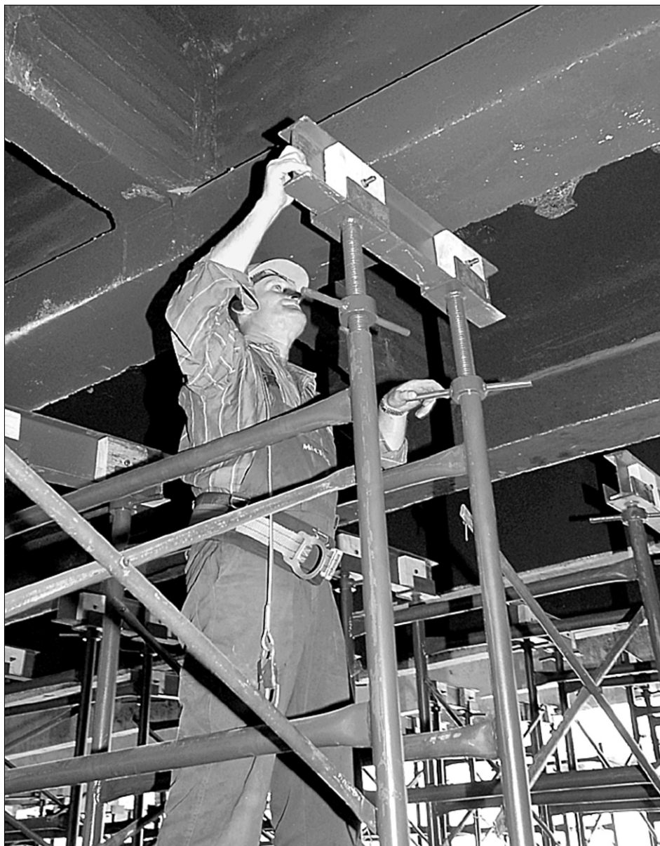
Нині будівельники монтують під Шулявським шляхопроводом тимчасові металеві підпори
